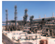
LNG Project (Qatar)
