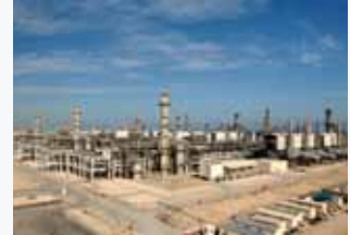
LNG Project in Qatar
