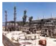
LNG Project (Qatar)
