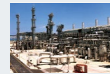
LNG project (Qatar)
